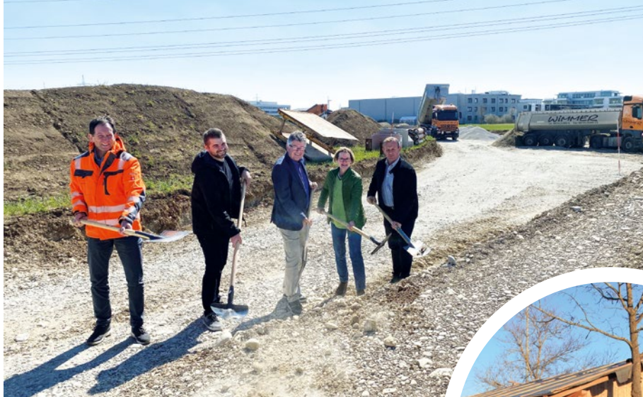
Spatenstich für die Verlängerung der Hermann-Oberth-Straße
